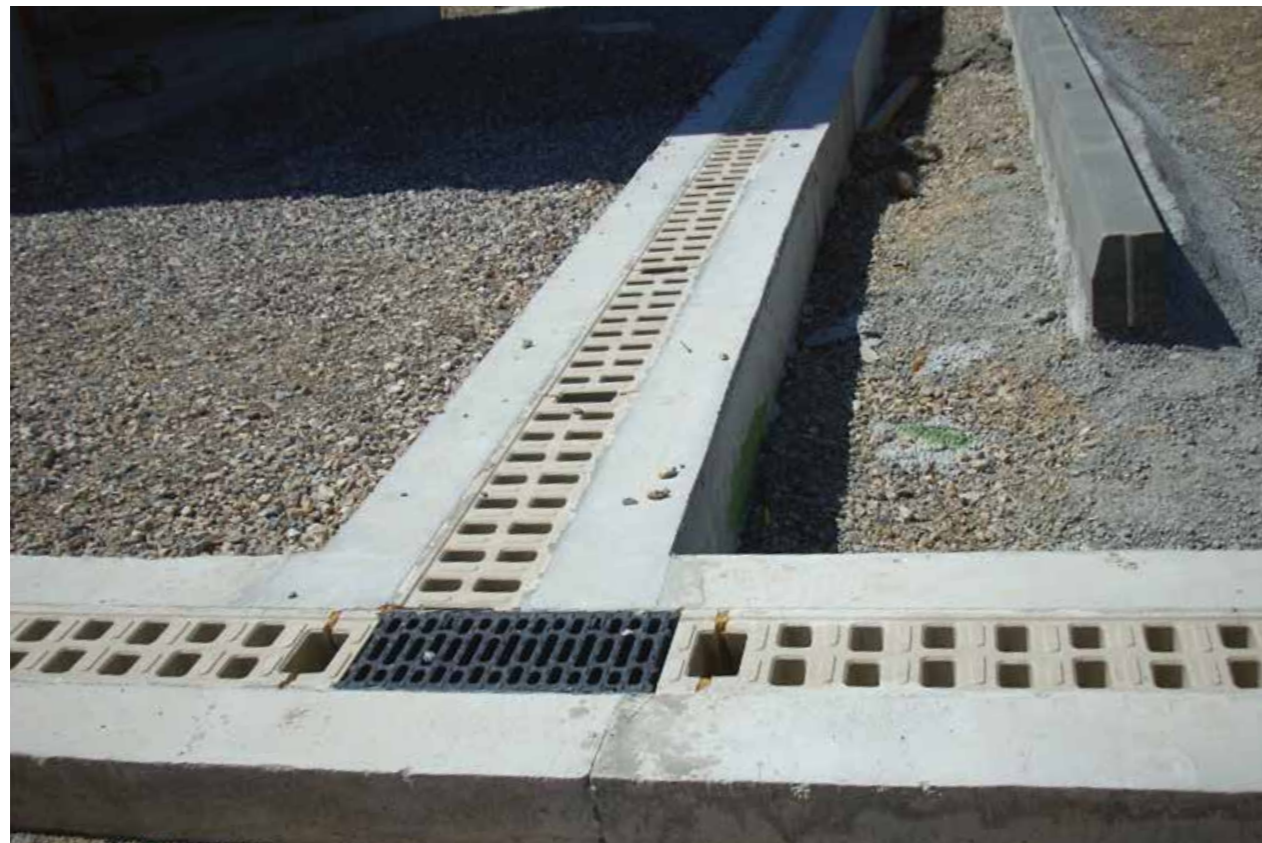
Каналы в бетонной обойме
