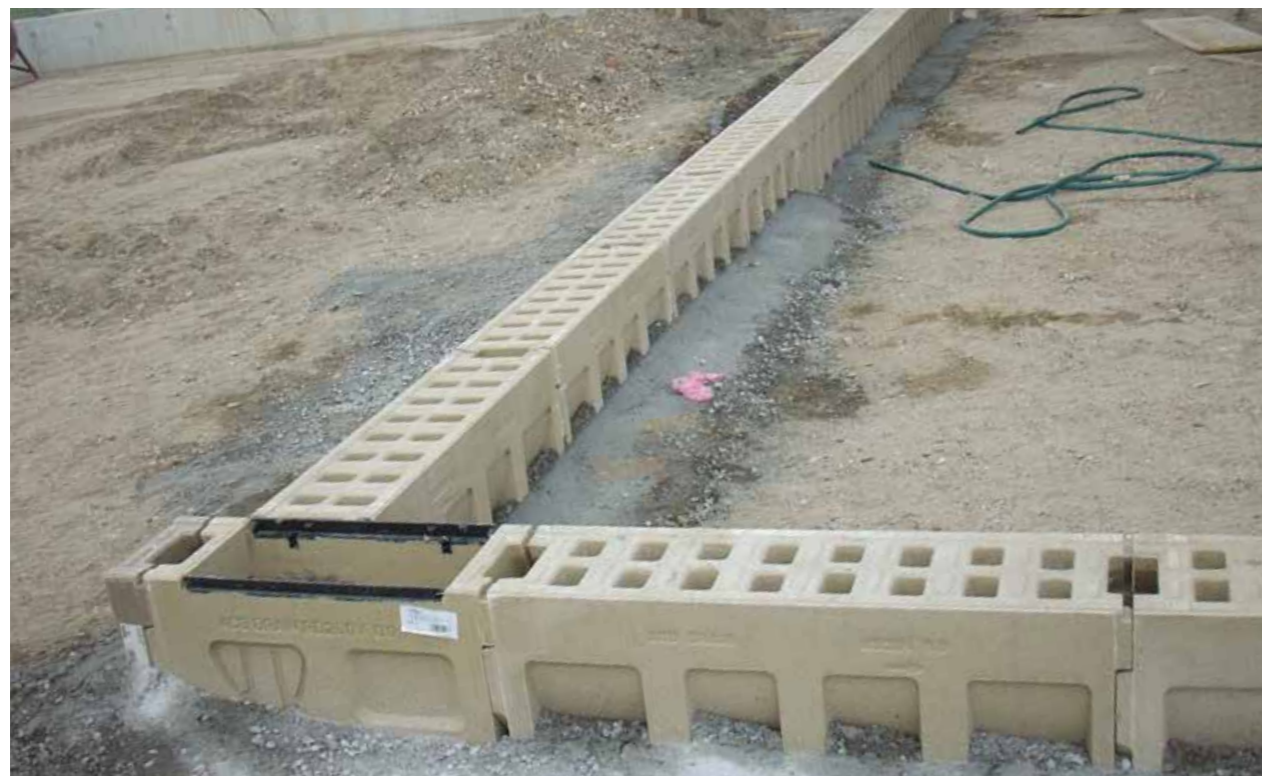
Устройство L-образного соединения каналов
