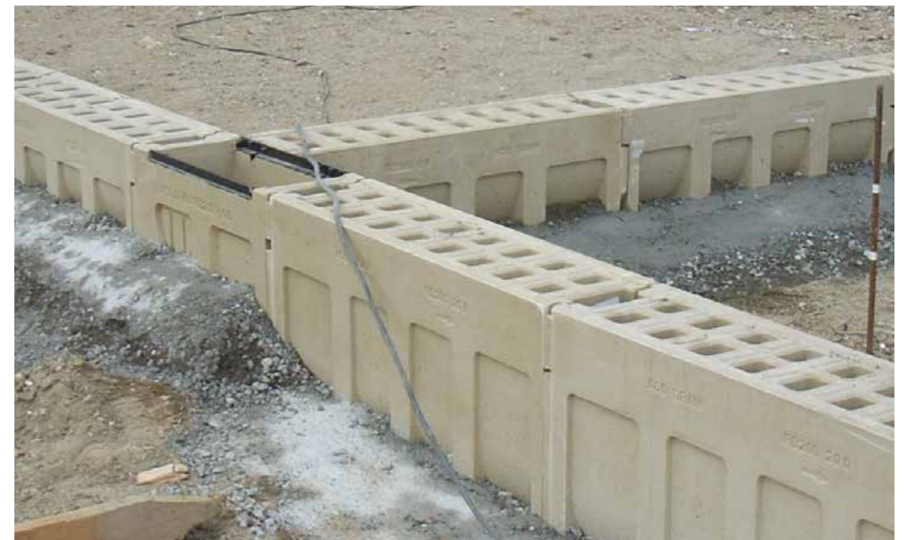
Устройство T-образного соединения каналов
