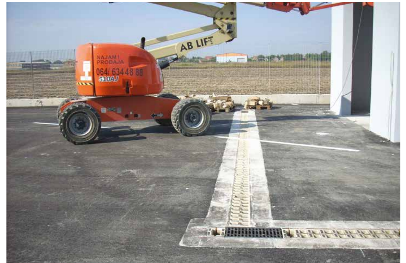
Каналы после укладки верхнего покрытия площадки
