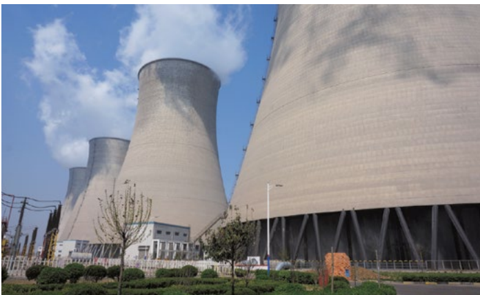
Шаньдунская электростанция Цзоупин
