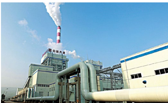
Тепловая электростанция Датанг Баоцзи
